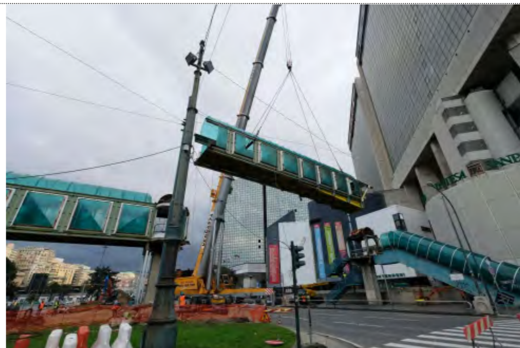
Con le prime luci dell'alba, si è iniziato ad affrontare il tratto più complicato (tratto D - fig.). La demolizione di questo segmento, lungo 26,68 m e pesante
