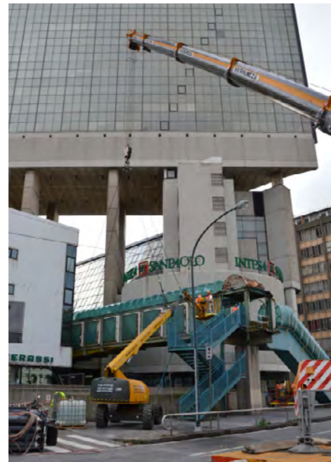
33 t, non essendo in appoggio su piloni come il precedente, bensì su una soletta in cemento posta tra i due edifici di Corte Lambruschini con la parte
