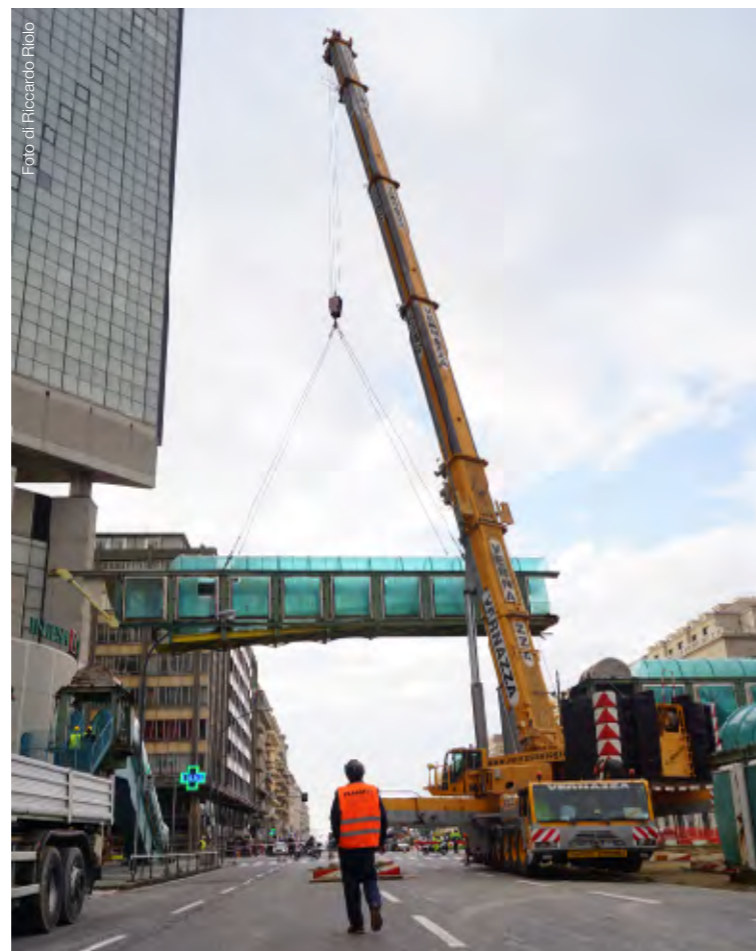
Con le prime luci dell'alba, si è iniziato ad affrontare il tratto più complicato (tratto D - fig.). La demolizione di questo segmento, lungo 26,68 m e pesante
